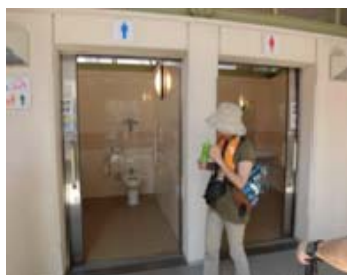
多機能トイレ（現状）
